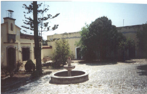
Patio Central y Fachada del Molino de San Miguel.
