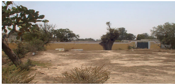
Paisaje agrario exterior del costado sur del Molino de San Miguel.
